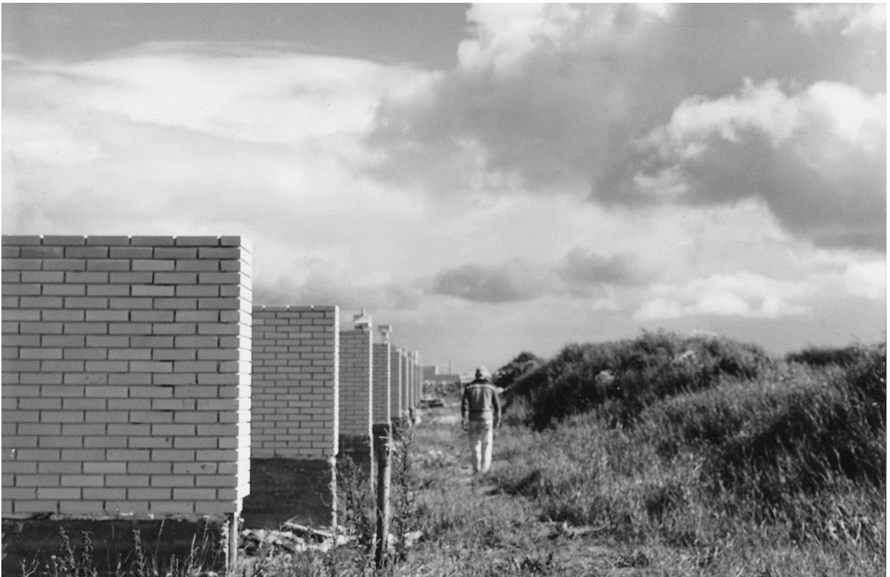
Korshøjen under opførelse i 1967, set mod øst.
