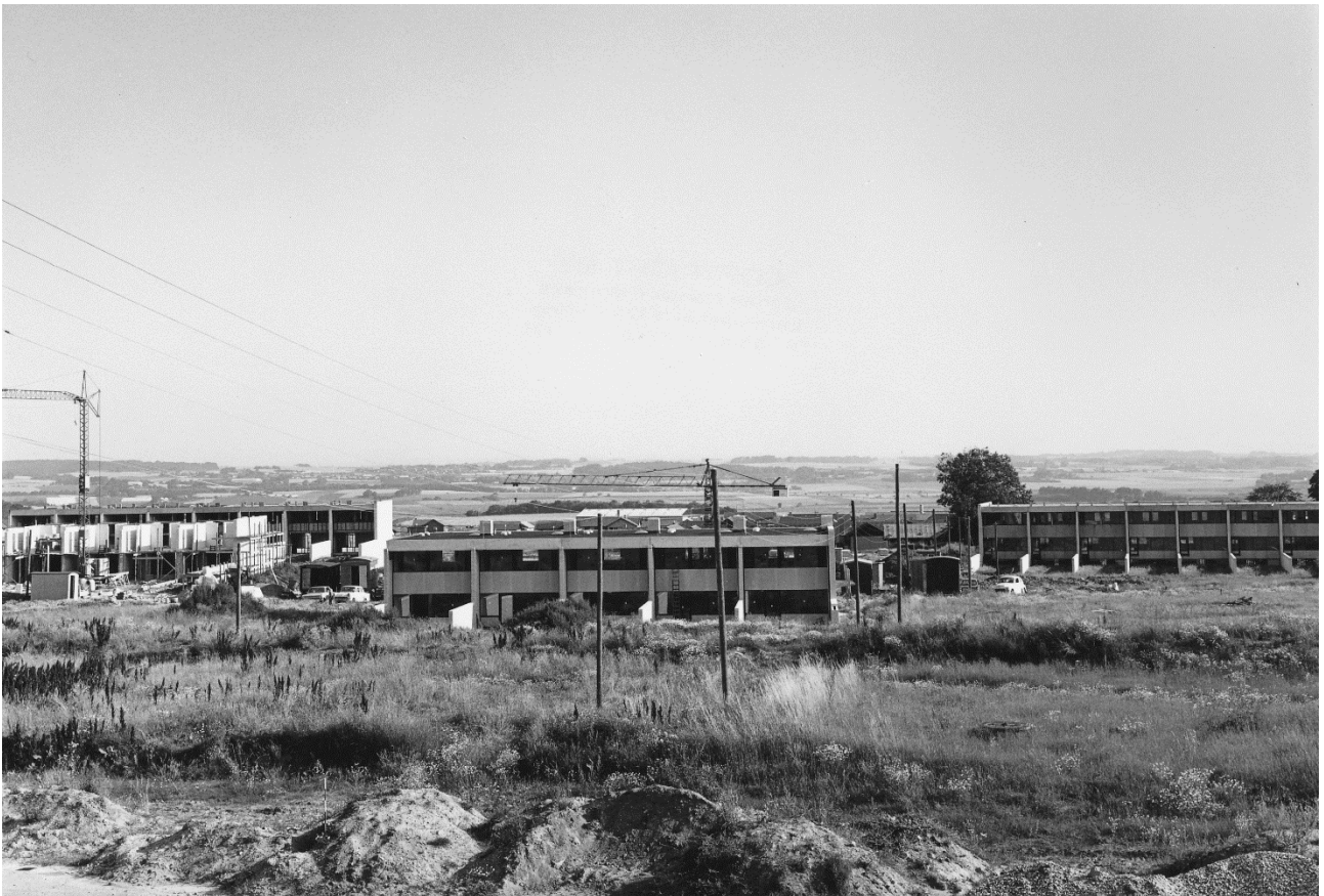
Byggeriet i fuld gang – Skodshøjen med Korshøjen i baggrunden, ca. 1970.
