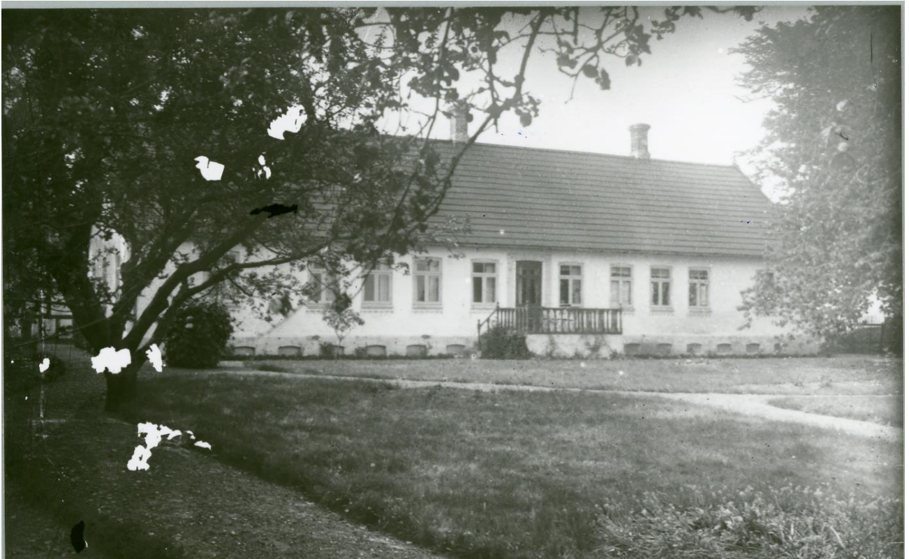
Stuehuset til gården Fredenslund, ca. 1930.
